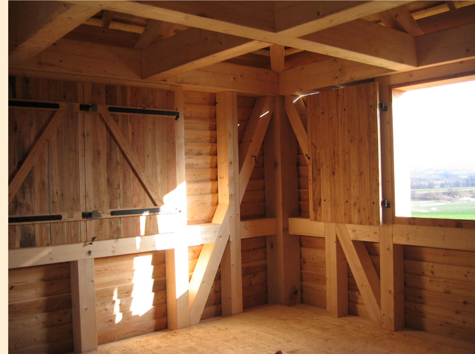
Sichtbares Fachwerk im Bereich des obersten Geschosses. An den Ecken waren bei dem Römer- und dem geplanten Turm Streben notwendig. Die Fenster sind daher nur in der Mitte der Fassade möglich.
